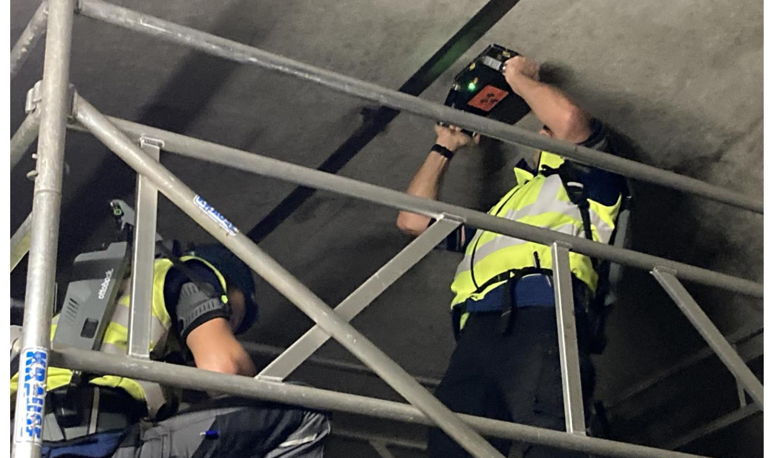
Exoskelett zur Unterstützung bei Bauwerksuntersuchung
