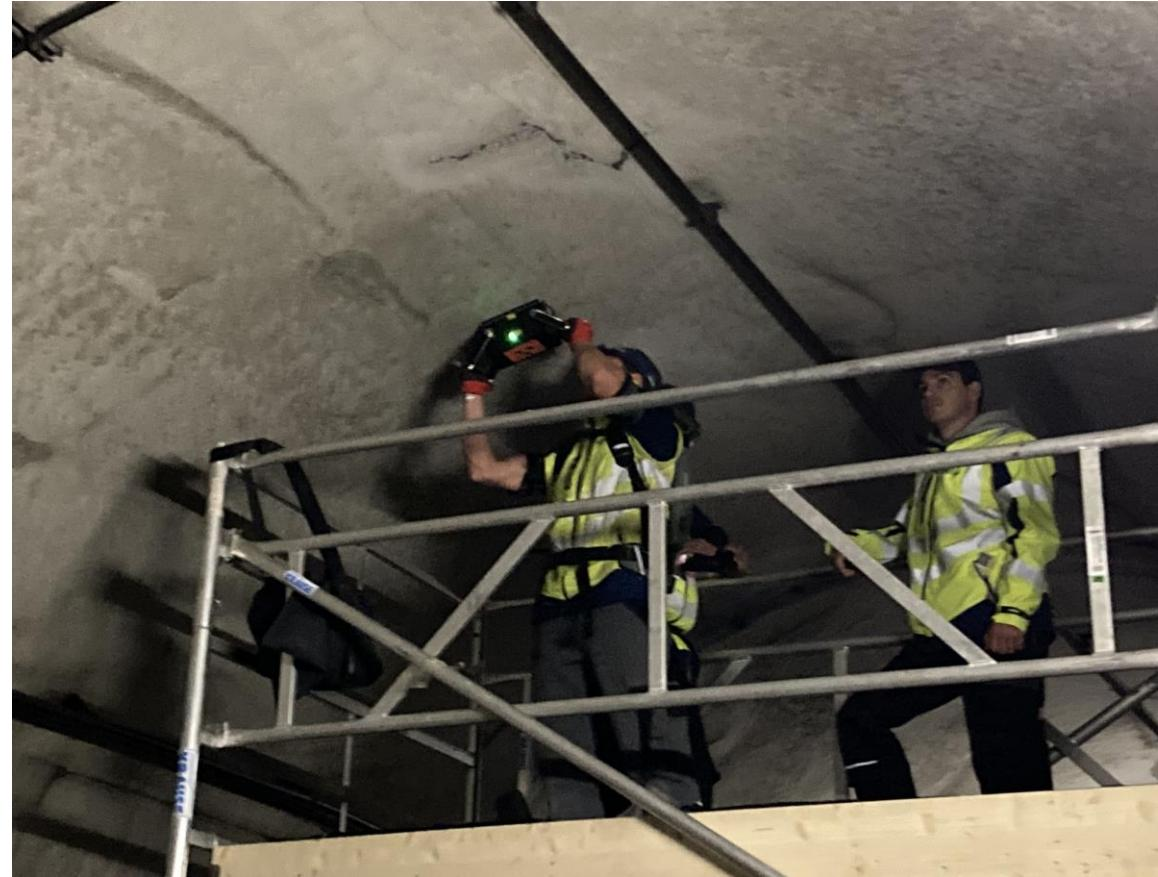
Exoskelett zur Unterstützung bei Bauwerksuntersuchung
